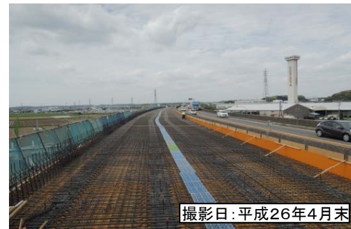
④沖之川高架橋
