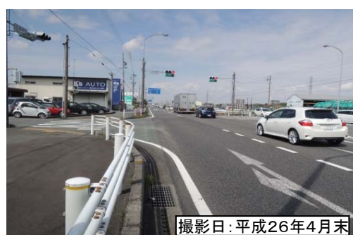
⑧久津部東交差点付近
