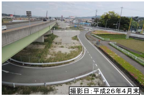
⑤国本高架橋
