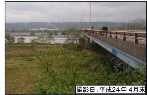
③新大井川橋
