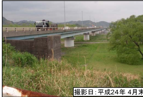
②新大井川橋
