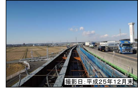
④沖之川高架橋
