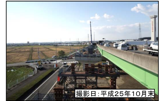
④沖之川高架橋
