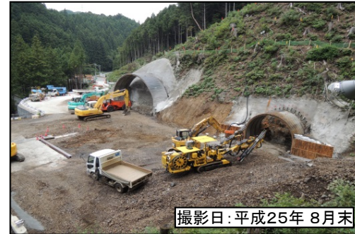
③佐久間第1トンネル(坑口)
