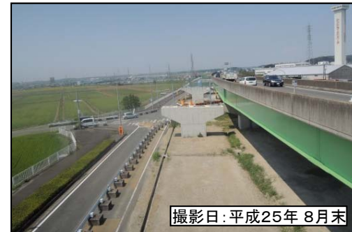
④沖之川高架橋
