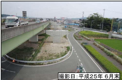
⑤国本高架橋
