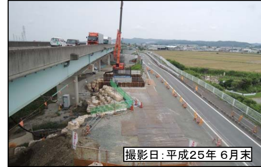
④沖之川高架橋
