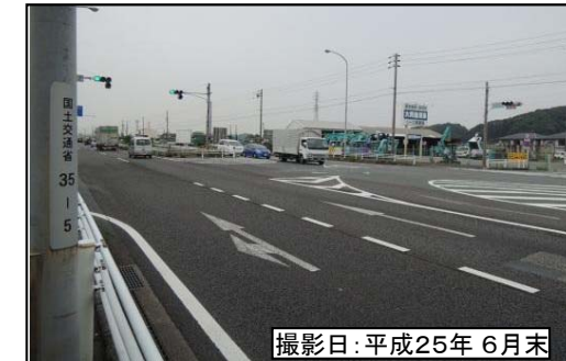
⑧久津部東交差点付近
