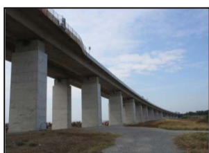
(耐震補強-橋脚補強)
