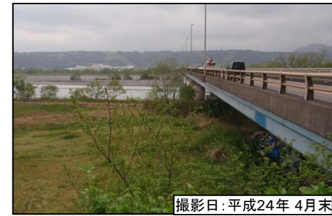
③新大井川橋
