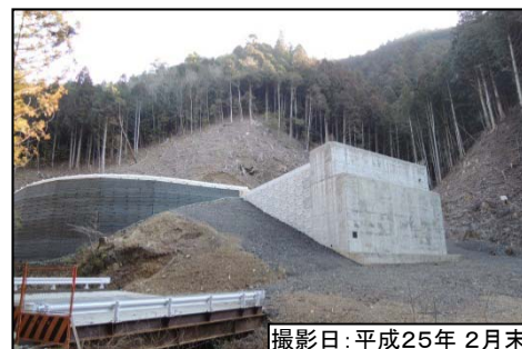
③佐久間第1トンネル(坑口)
