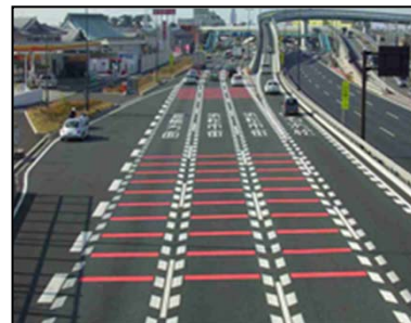
(安新横断歩道橋交差点) 速度注意を促すために路面標示等を実施。
