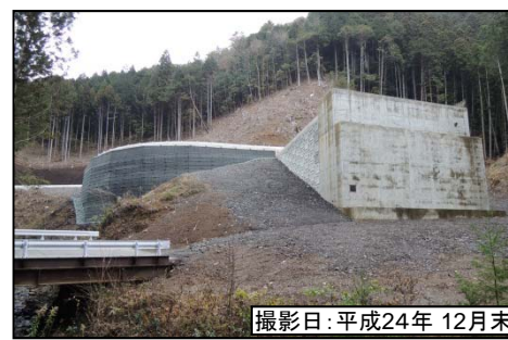
③佐久間第1トンネル(坑口)
