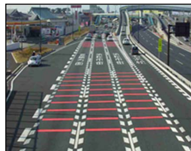
(安新横断歩道橋交差点) 速度注意を促すために路面標示等を実施。
