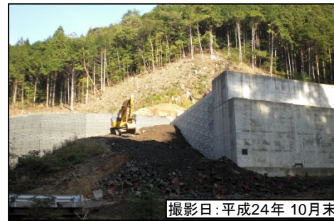
③佐久間第1トンネル(坑口)
