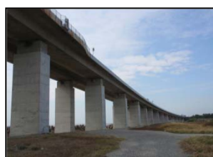
(耐震補強-橋脚補強)
