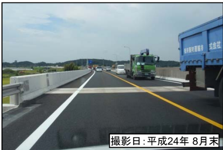
⑤土橋高架橋
