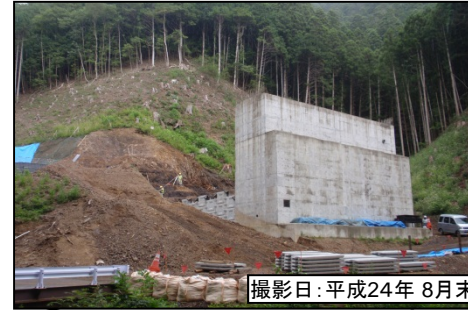
③佐久間第1トンネル(坑口)
