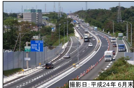
③中川上橋
