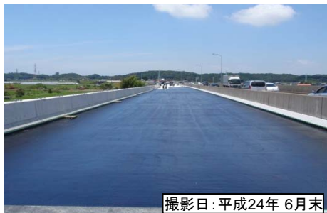
⑤土橋高架橋
