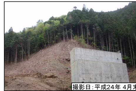
③佐久間第1トンネル(坑口)
