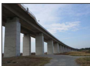
(耐震補強-橋脚補強)
