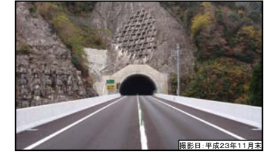
④ 三遠トンネル (飯田側坑口)
