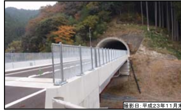
② 別所8号橋梁・別所トンネル
