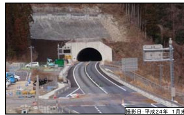
⑥ 三遠名号トンネル (引佐側坑口)
