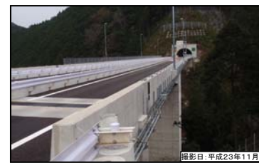
⑦ 名号高架橋
