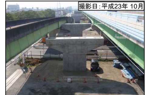
⑦堀越高架橋
