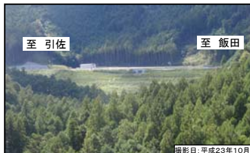
⑦ 大島盛土
