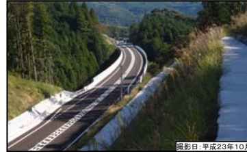
③ 別所3号高架橋(仮称)
