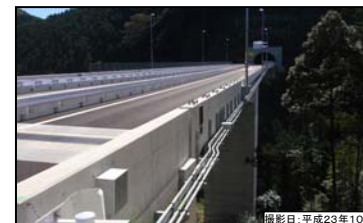
⑨ 名号高架橋(仮称)
