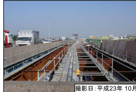
⑥土橋高架橋
