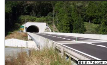
⑤ 久井田高架橋(仮称) 久井田トンネル(仮称)
