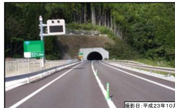
⑧ 名号トンネル(仮称) 引佐側入口
