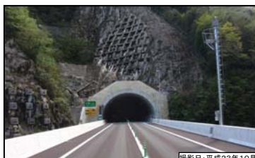
⑥ 三遠トンネル(仮称) 飯田側入口
