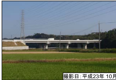
②山根高架橋
