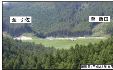
⑦ 大島盛土
