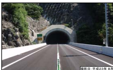
⑥ 三遠トンネル(仮称) 飯田側坑口
