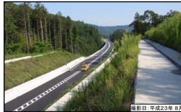
③ 別所3号高架橋(仮称)
