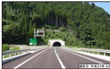
⑧ 名号トンネル(仮称) 引佐側坑口
