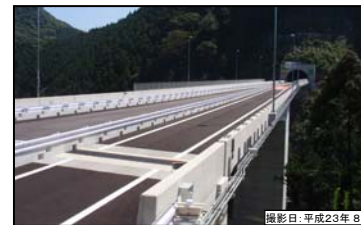
⑨ 名号高架橋(仮称)
