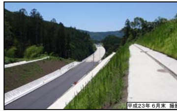
③ 別所3号高架橋(仮称)
