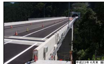
⑨ 名号高架橋(仮称)
