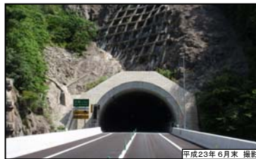
⑥ 三遠トンネル(仮称)飯田側入口
