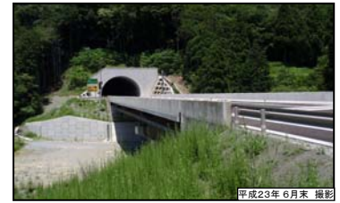
⑤ 久井田高架橋(仮称)別所トンネル(仮称)
