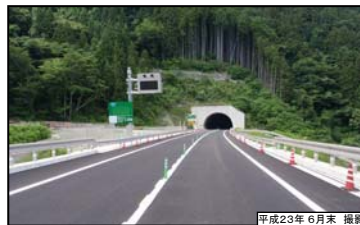
⑧ 名号トンネル(仮称) 引佐側入口
