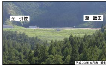
⑦ 大島盛土
