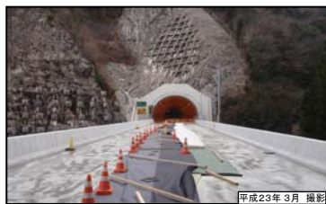
⑥ 三遠トンネル(仮称)飯田側入口
