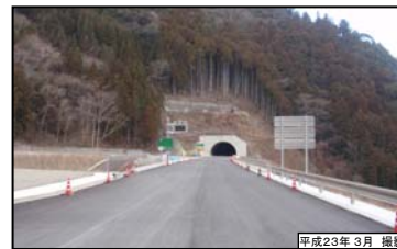
⑧ 名号トンネル(仮称) 引佐側入口
