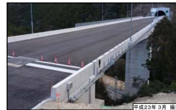
⑨ 名号高架橋(仮称)
