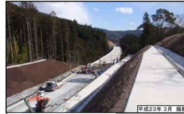
③ 別所3号高架橋(仮称)
