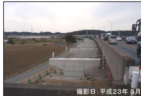
⑥土橋高架橋
