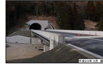
⑤ 久井田高架橋(仮称)別所トンネル(仮称)
