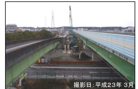
⑦堀越高架橋
