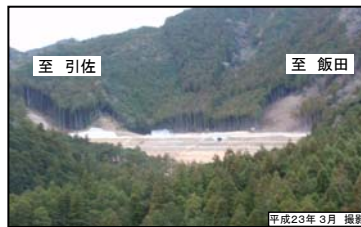
⑦ 大島盛土
