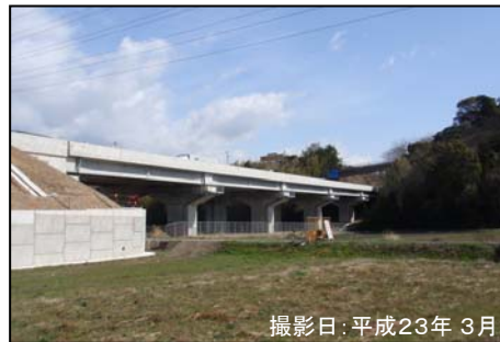
②山根高架橋
