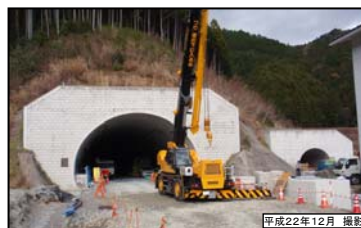
⑥ 三遠トンネル(仮称)引佐側坑口
