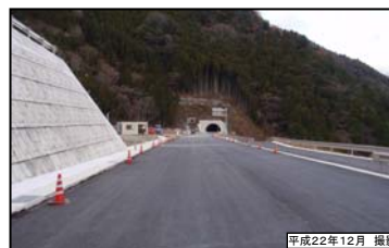
⑧ 名号トンネル(仮称) 引佐側坑口
