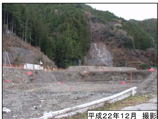
② 浦川地区現況
