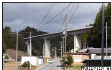
③ 別所3号高架橋(仮称)
