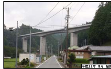
③ 別所3号高架橋(仮称)
