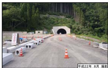
⑧ 名号トンネル(仮称)引佐側坑口
