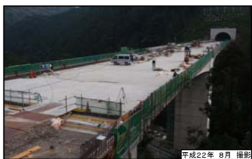
⑨ 名号高架橋(仮称)
