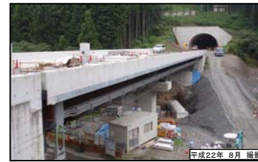
⑤ 久井田高架橋上部(仮称)別所トンネル(仮称)
