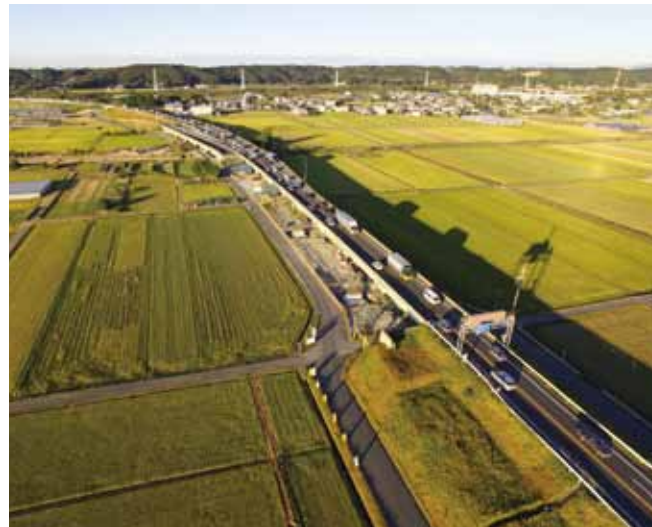
袋井バイパス堀越IC付近より浜松市方面を望む (平成22年10月撮影)
