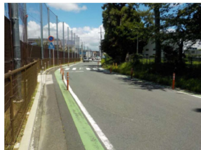
車道幅員の狭小（ラバーポールの設置）
