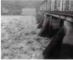
S58洪水/船明ダム出水状況
