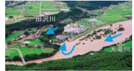
狭窄部上流の浸水状況
