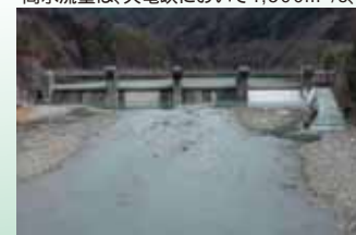
中部電力南発電所取水堰堤(昭和4年完成/土木遺産)
