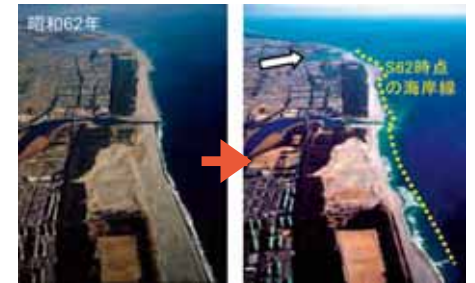
漂砂の遮断等により海岸線が後退
