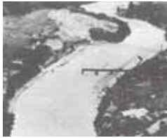
S43洪水/落橋したJR飯田線大千瀬鉄橋
