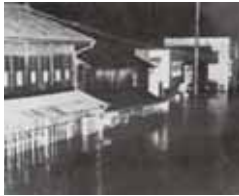
S43洪水/浜松市天竜区横山地区の被災状況
