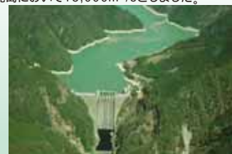
佐久間ダム(昭和31年完成)
