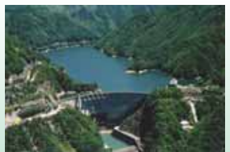
小渋ダム(昭和44年完成)
