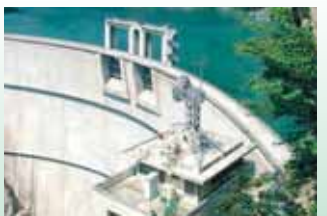
新豊根ダム(昭和48年完成)
