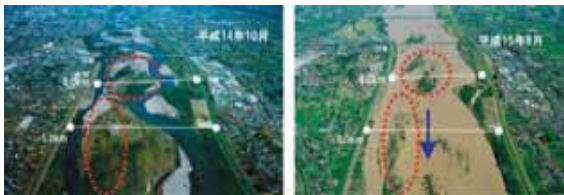
河道内樹木による洪水流下障害・樹木流木化(安間川合流点上流 5.0km付近)
