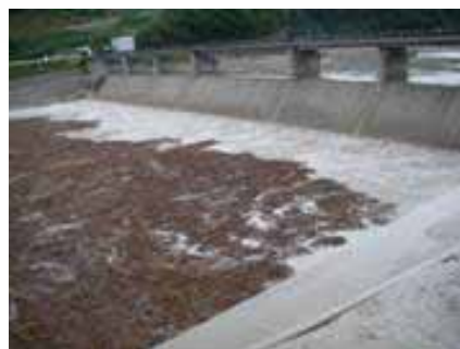
分派堰(三峰堰)
