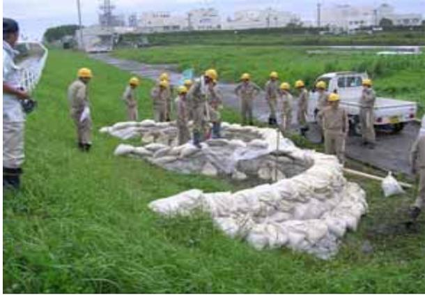
堤体からの漏水への対策(月の輪)事例
