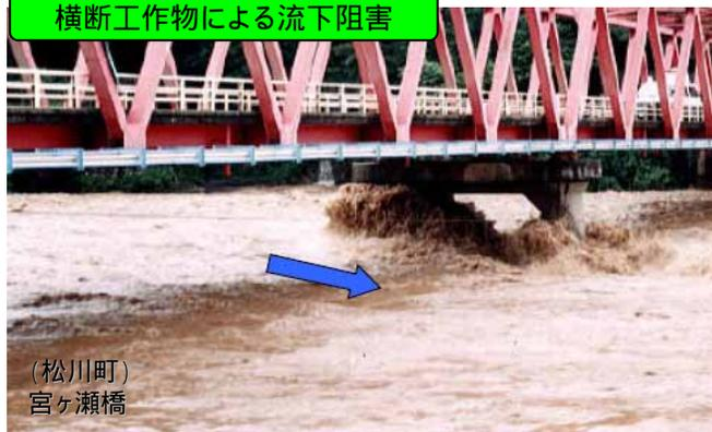
・橋、堰など河川を横断する工作物が、洪水流下を阻害している箇所もある。
