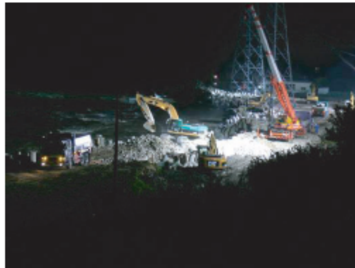
⑤7/23 1時 緊急復旧工事の根固ブロック投入状況
