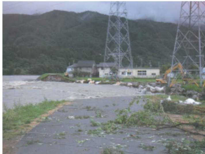
②7/20 9時 応急復旧工事施工中(上流側から)
