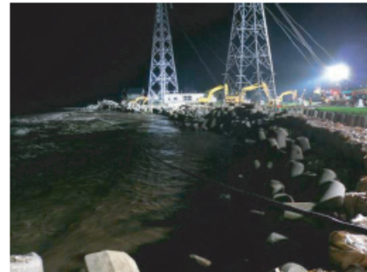
③7/21 19時30分 応急復旧工事完了
