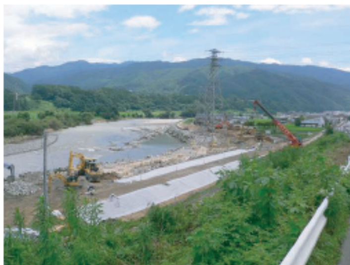
⑦7/27 12時 進入路を除き築堤盛土完了
