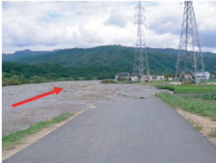
①7/19 堤防決壊直後(上流側から)
