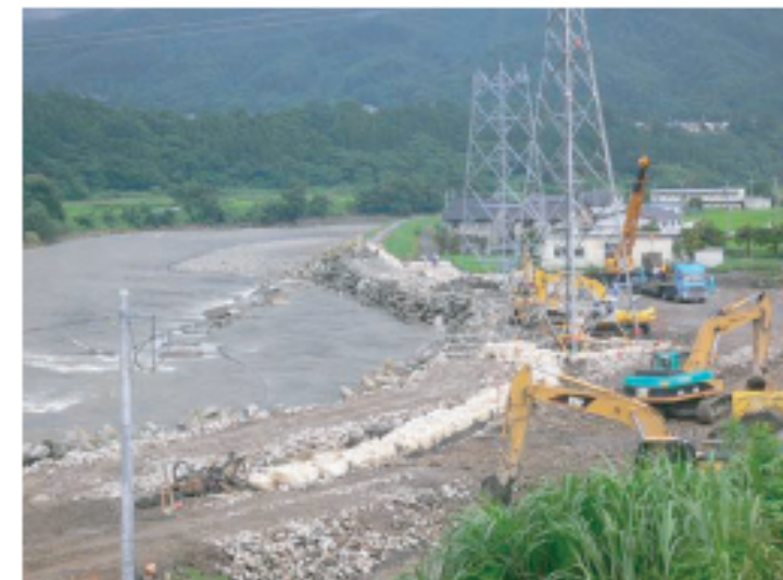
⑥7/24 15時 緊急復旧工事の根固ブロック投入完了
