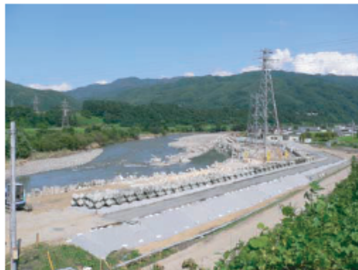
⑧7/30 15時 大型連節ブロック張完了
