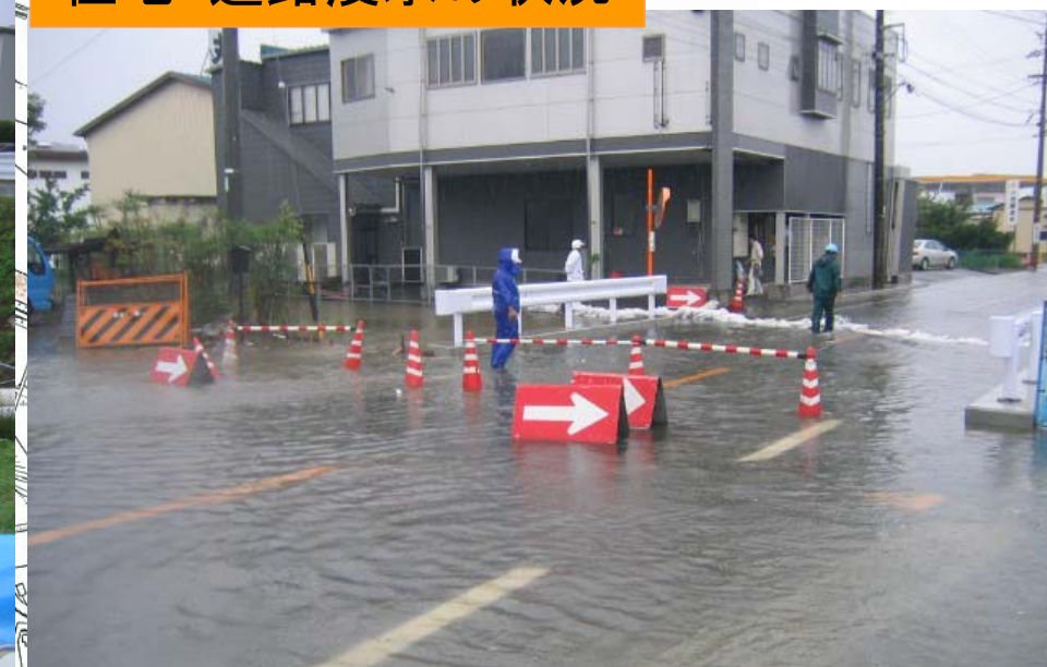
住宅・道路浸水の状況
