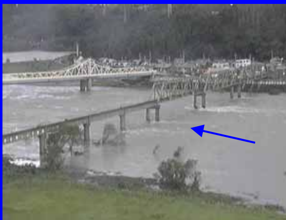
鹿島地点における出水状況 H16.10.21撮影
