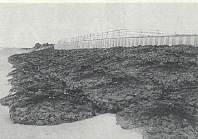
応急工事で防護網とネットの石(手前)に囲まれたゴミ流出現場＝浜松市中田島砂丘
