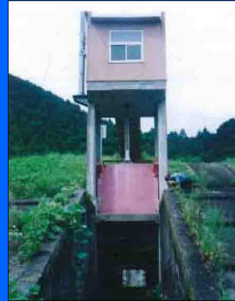
堤防の沈下により、樋管と護岸の間に出来た隙間 護岸の裏に空洞があり洪水時に危険
