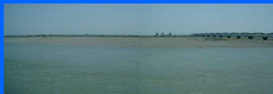
② 8.0km付近(右岸から左岸方向)
