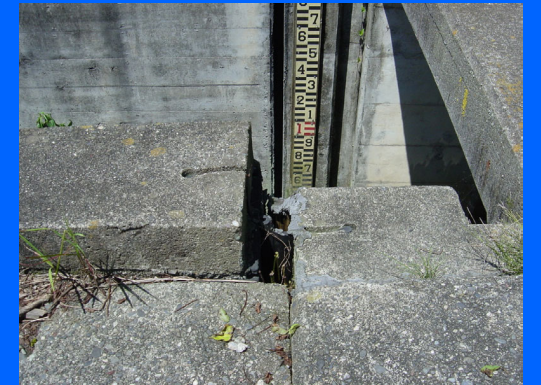
堤防の沈下により、樋管と護岸の間に出来た隙間 護岸の裏に空洞があり洪水時に危険
