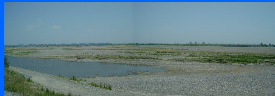
①7.0km付近(右岸から左岸方向)
