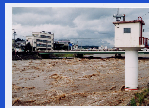
水防上重要な箇所
