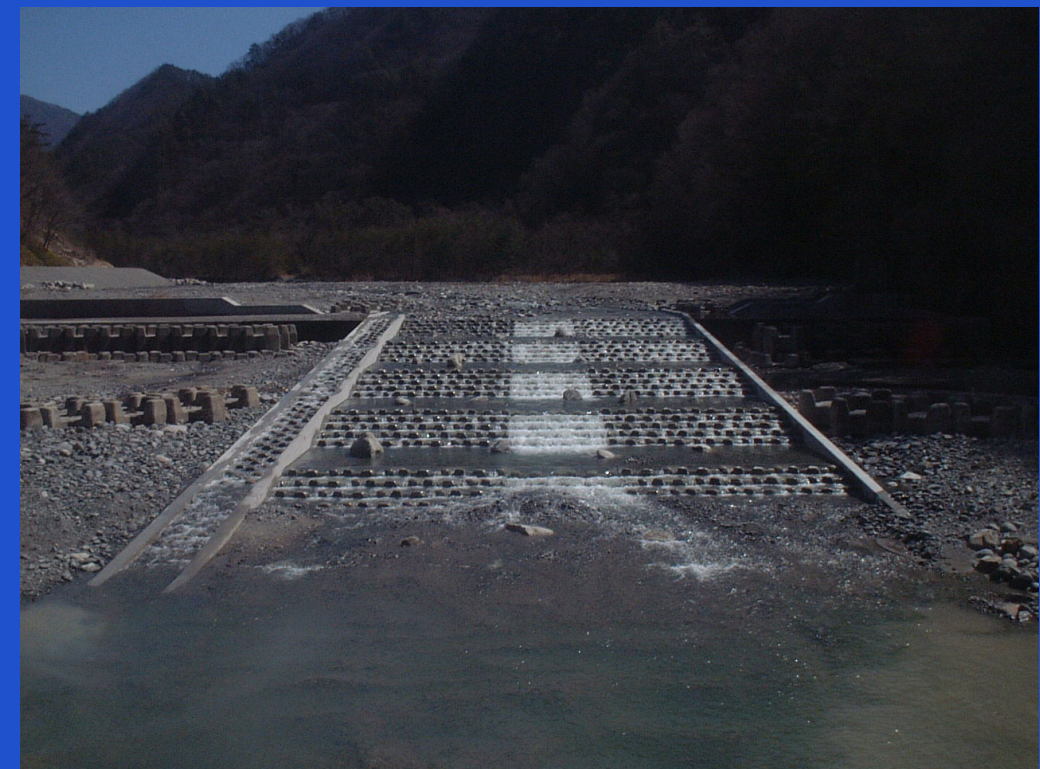
床固工の魚道(生田第2床固[小渋川]、松川町・中川村)
