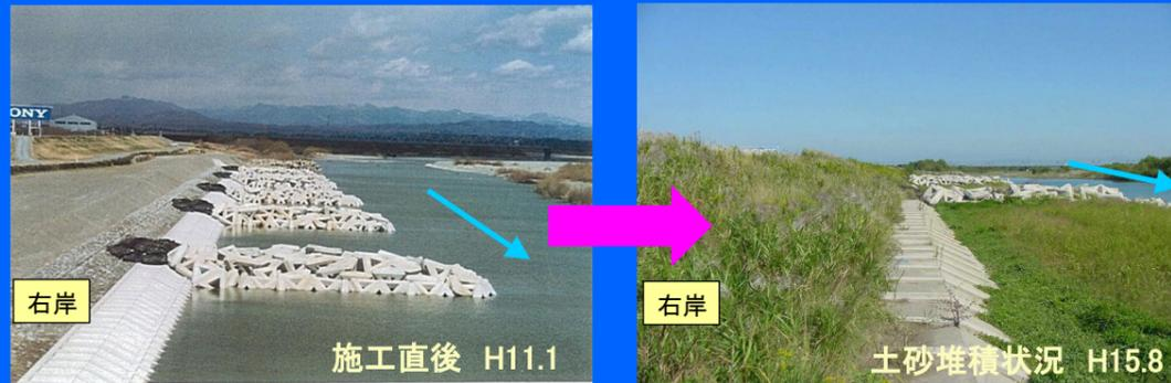
水制付近の土砂堆積状況(河口から5.0km付近右岸)
