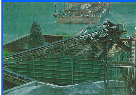
浚渫船(上)と揚砂場(下)
