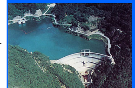
新豊根ダム全景
