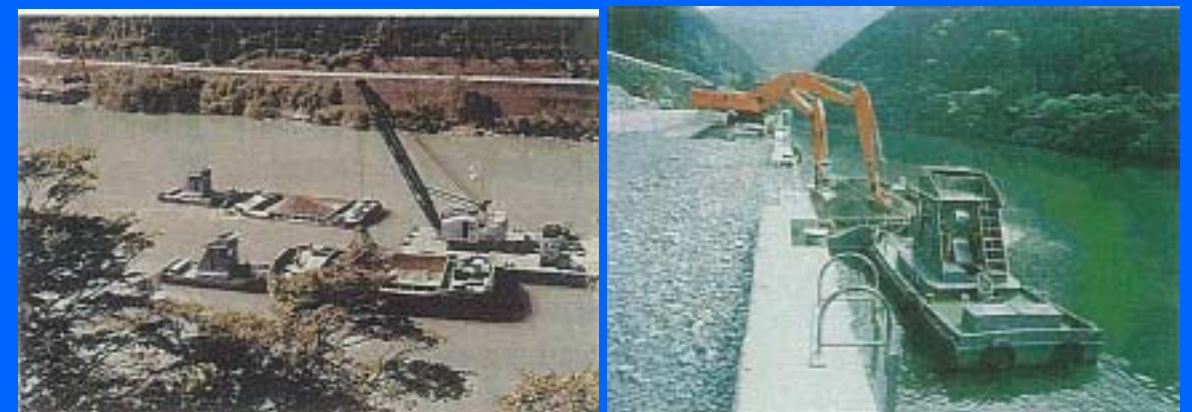
秋葉ダムにおける浚渫状況(左)と場外搬出状況(右)
