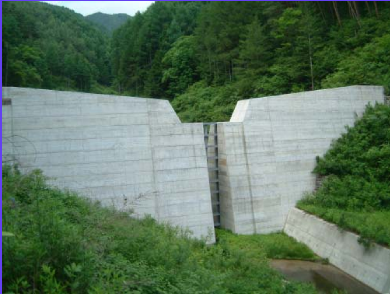
猪鹿沢第3砂防えん堤(三峰川水系、高遠町)
