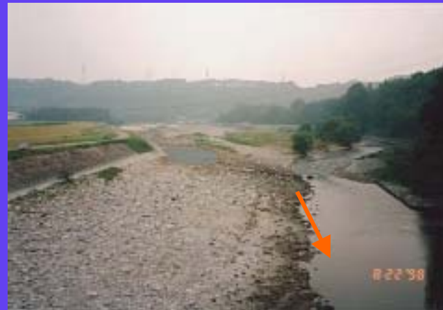
南向えん堤下流部
