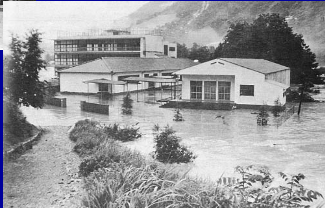
佐久間小学校浸水状況
