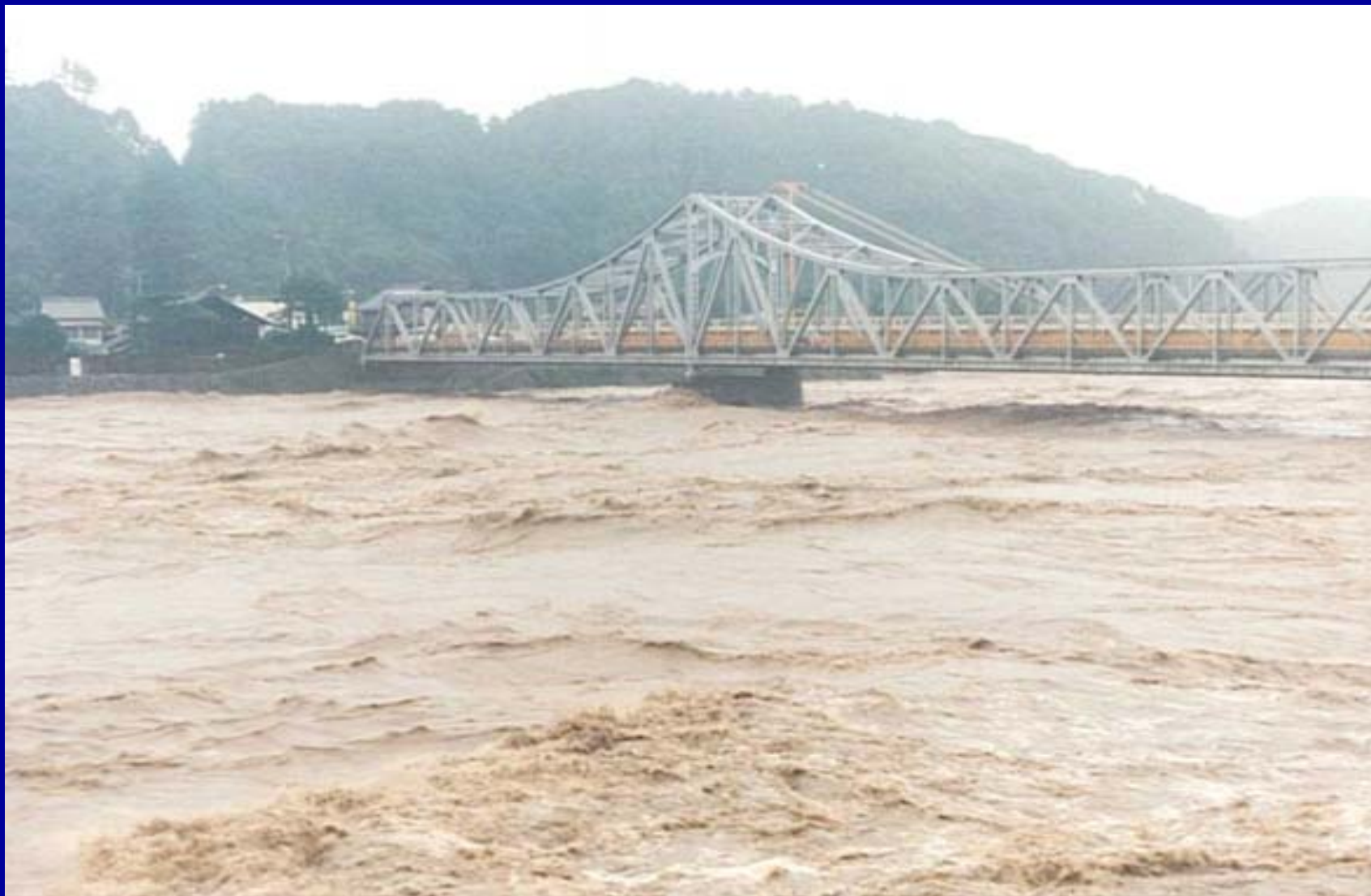
鹿島付近の出水状況
