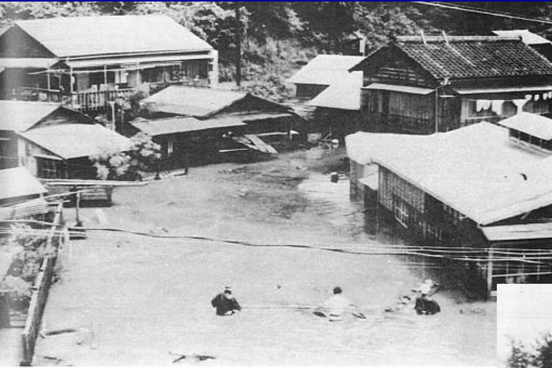
佐久間町氾濫浸水状況
