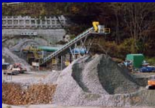
洪水バイパストンネル
