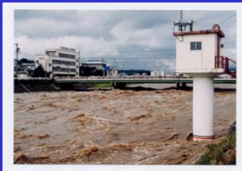
水防上重要な箇所
