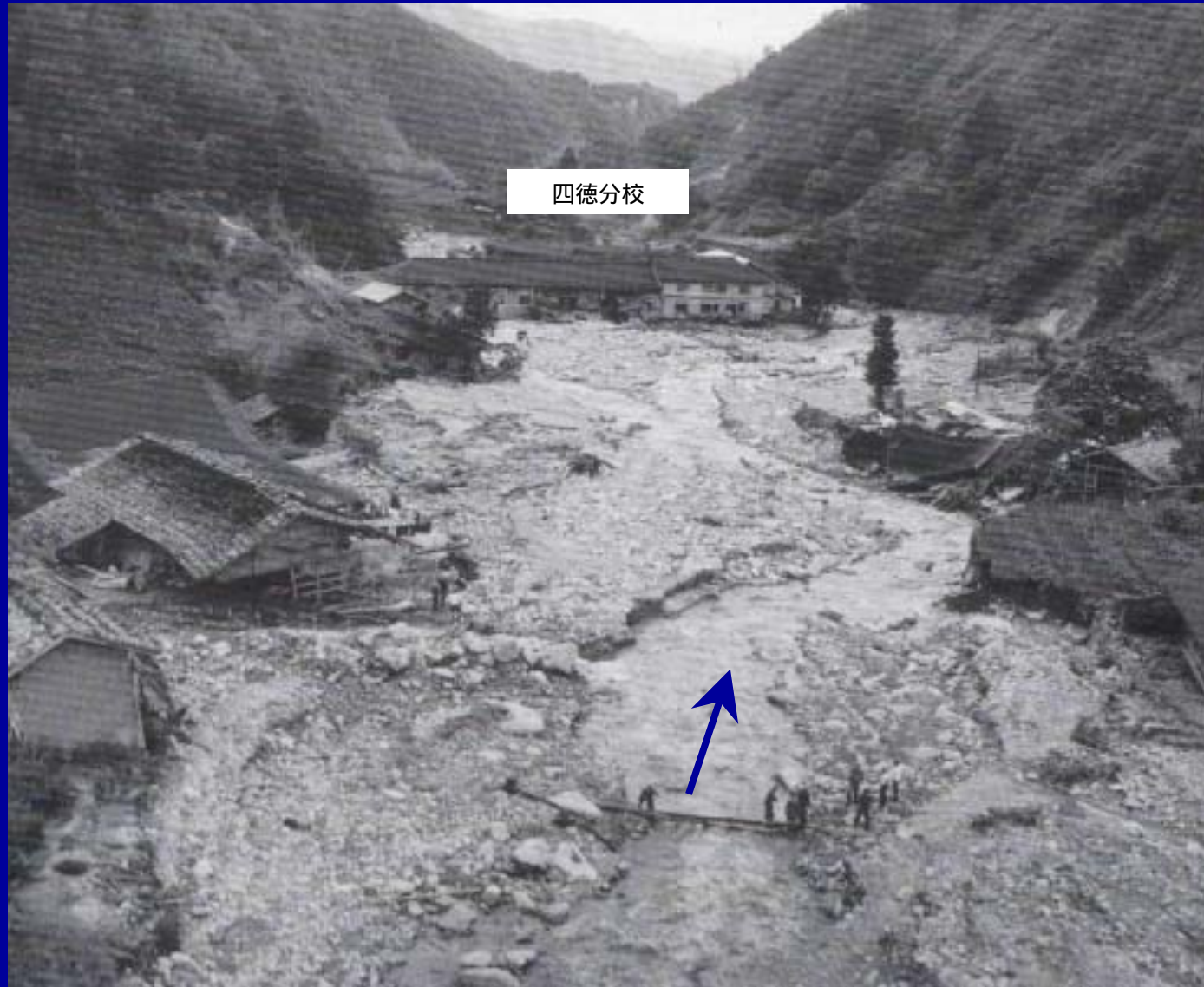
中川村四徳地先(昭和36年6月)
