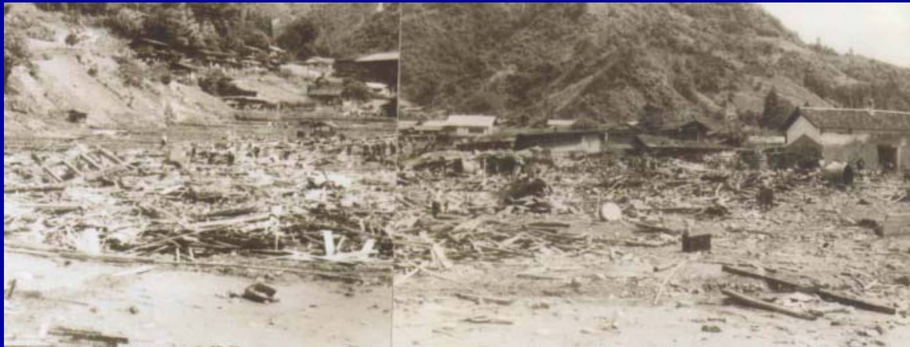
大鹿村大西山 (崩落後の文満(ぶんまん)集落の惨状)
