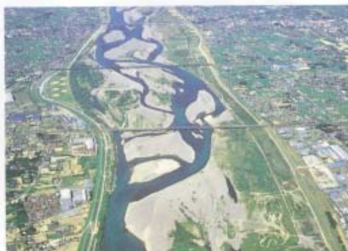
●天竜川漏水対策
