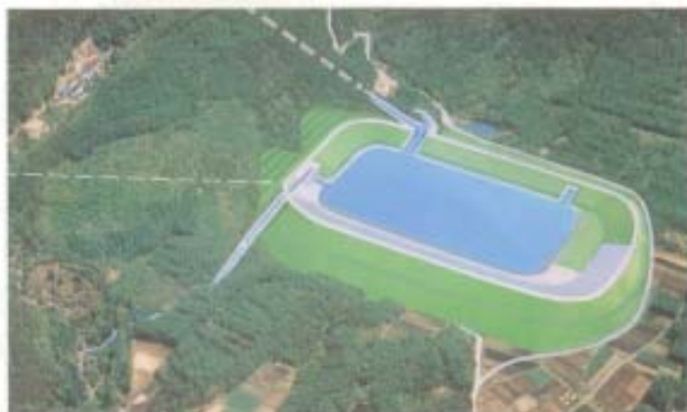
⑦蓼科治水ダム建設事業“蓼科ダム”(上川;長野県茅野市豊平)
