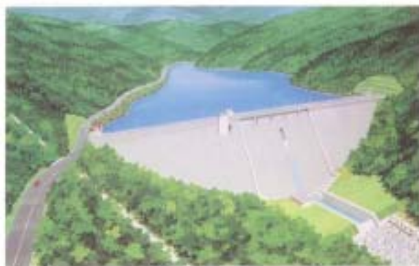
④紙川総合開発事業“下諏訪ダム” (東俣川;長野県諏訪郡下諏訪町東俣)
