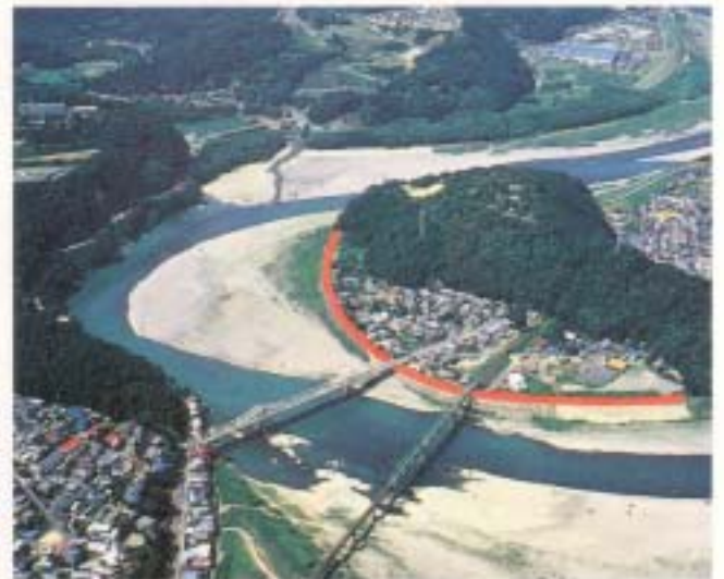
②北鹿島地区改修(静岡県天竜市北鹿島)
