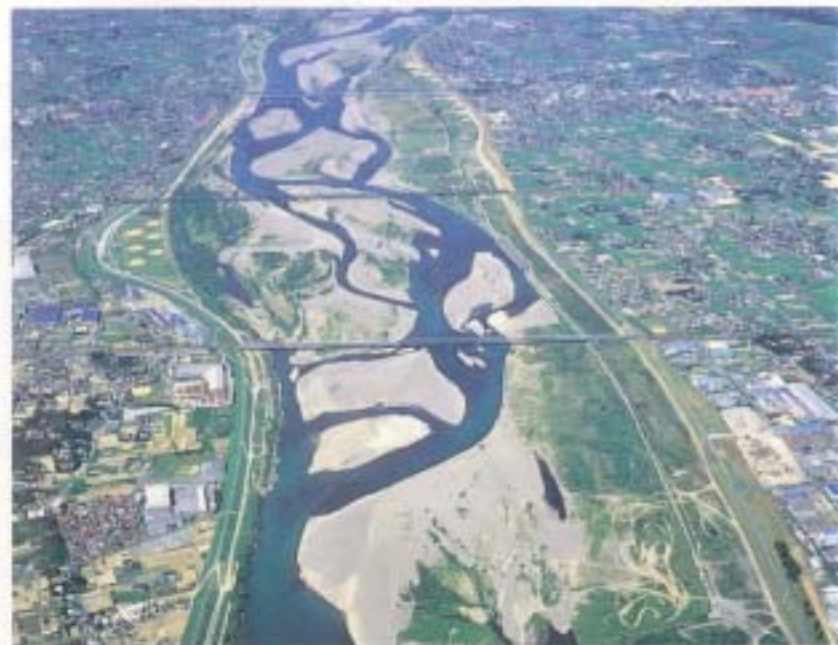
④天竜川漏水対策(静岡県浜松市・浜北市・竜洋町・豊田町・磐田市・豊岡村)
