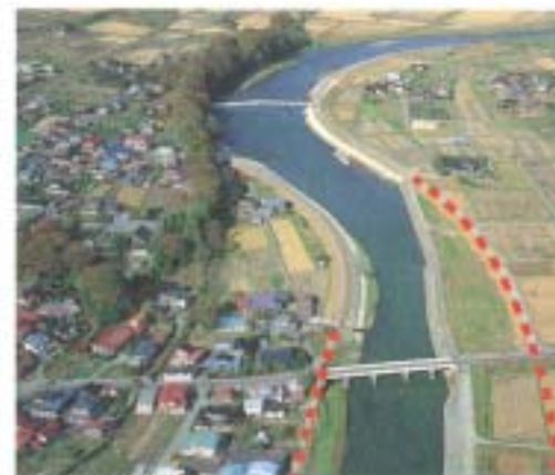
伊北地区改修
