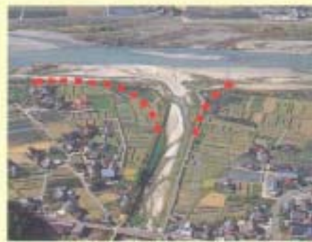
④小川川合流処理
