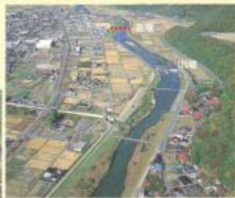
③三日町頭首工改築
