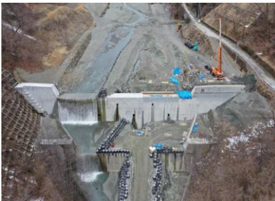
土砂流出対策 (砂防堰堤の設置)
