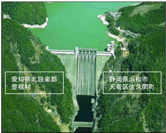
佐久間ダム(電源開発(株)S31完成)
