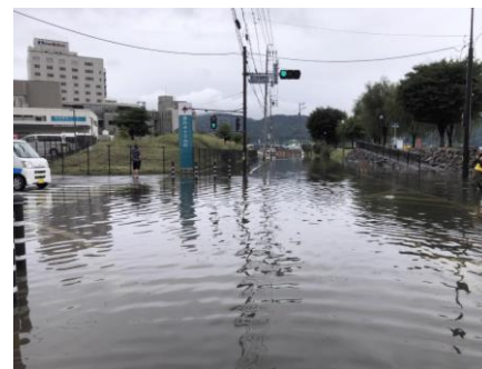
R3.8洪水による浸水状況(諏訪市)
