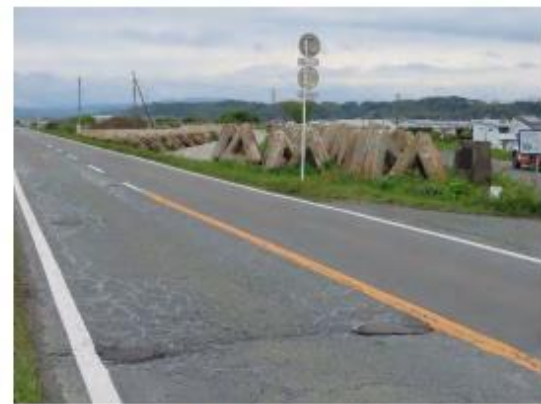
左岸 11.8k付近に備蓄されている根固めブロック等
