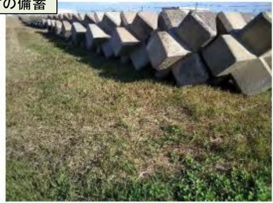
左岸 6.0k付近に備蓄されている根固めブロック等
