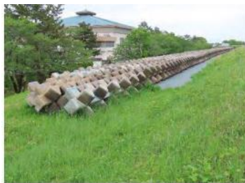
左岸 19.6k付近に備蓄されている根固めブロック等
