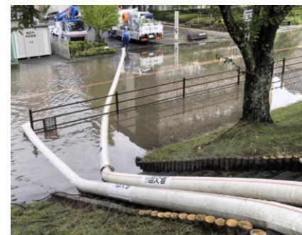
排水ポンプ車による排水状況
