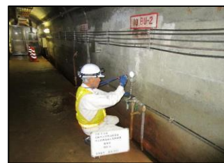
ダム堤体内における漏水量・揚圧力調査の状況
