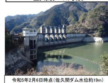
令和5年2月6日時点(佐久間ダム水位約19m)
