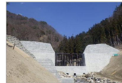
滝沢第2砂防堰堤(大鹿村・中川村)
