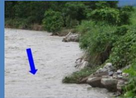
④三峰川右岸4.6k付近 堤防の欠損
