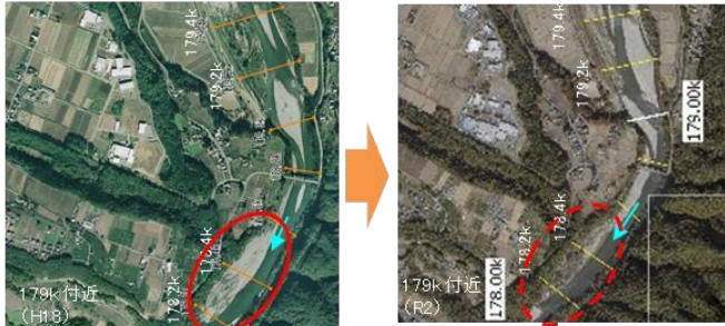
※自然再生事業で再生した砂礫河原は維持されているが(179.2～179.4k右岸付近)、一部の範囲で樹林化による砂礫河原の減少がみられる(178.2～178.4k右岸付近)
