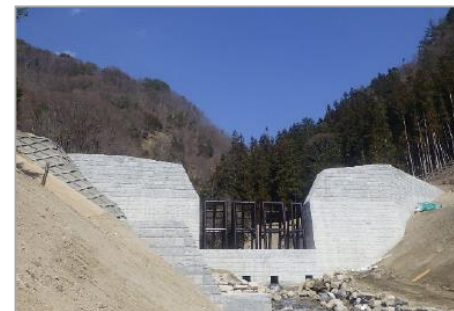
滝沢第2砂防堰堤（大鹿村・中川村）
