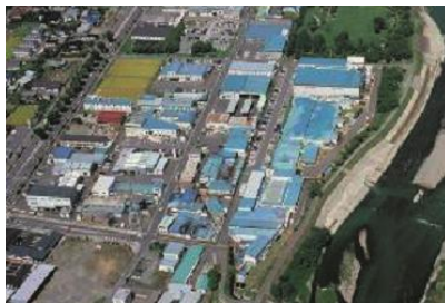
天竜川沿いの工場
