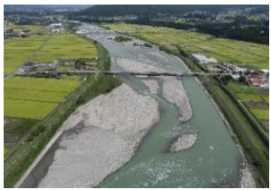
下平3工区付近の礫河原 (R3年9月)
