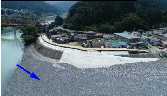
改修後(未完成:R4.3時点)
