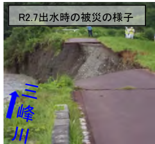
三峰川右岸4.6k付近 堤防の欠損 天竜川左岸151.4k付近 護岸一部流出
