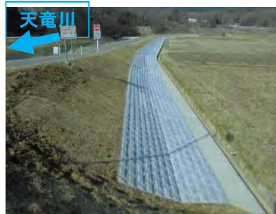
209.2kp(左岸) 堤防裏法尻の補強
