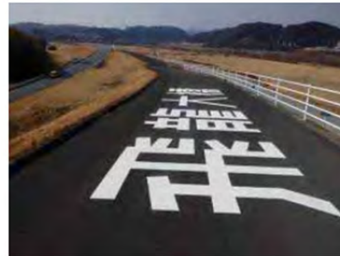
23.6kp(右岸) 堤防天端の保護
