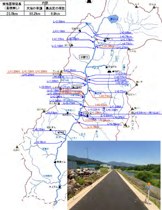
188.4kp(右岸) 堤防天端の保護
