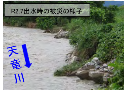
三峰川右岸4.6k付近 堤防の欠損 天竜川左岸151.4k付近 護岸一部流出
