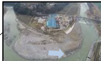
令和元年度 天竜川葛島護岸工事 ※R2年度 完成
