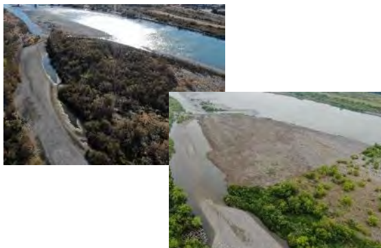
河道内に繁茂した樹木の伐開
