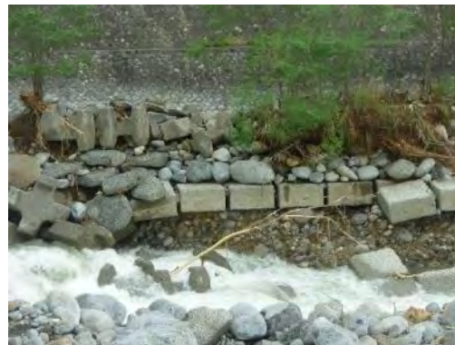
河川管理施設の点検
