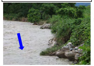
天竜川左岸151.4k付近護岸の一部流出
