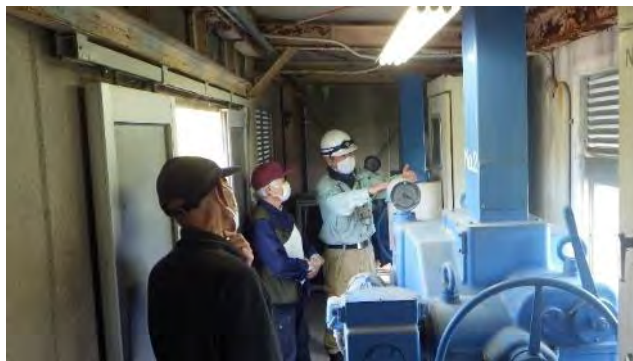
樋門の操作説明会
