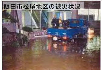
飯田市松尾地区の被災状況
