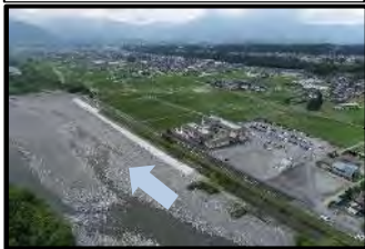
令和2年度 三峰川護岸災害復旧工事 ※R2年度完成
