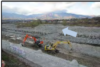
令和3年度 貝沼地区護岸工事 ※実施中
